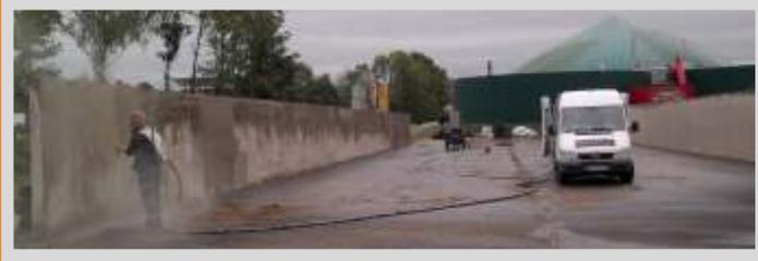
Die zuvor grob gereinigte Oberfläche wird mit einer Sandstrahlanlage abgetragen. Anschließend wird die freigelegte Betonoberfläche neu beschichtet.
